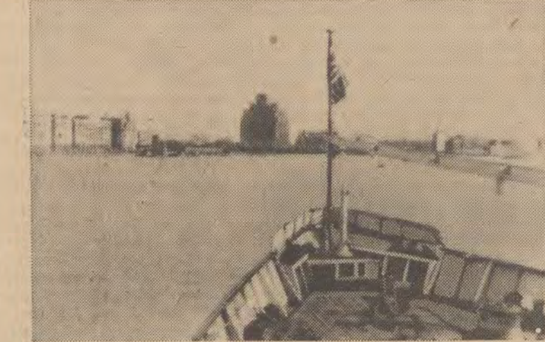
Einfahrt in Schanghai, im Hintergrund das Schanghai-Hotel
