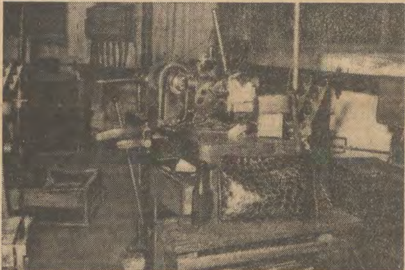
In MW 4 steht die sogenannte „Treptower Maschine“, eine Revolverdrehbank, der an und für sich nicht viel fehlt. Es ist nur die Kupplung nicht in Ordnung. Zur Zeit dient diese Revolverdrehbank als Ablage. Ich will endlich in Ordnung sein und auch solch nette Kollegin bei mir haben wie die anderen meiner Abteilung
