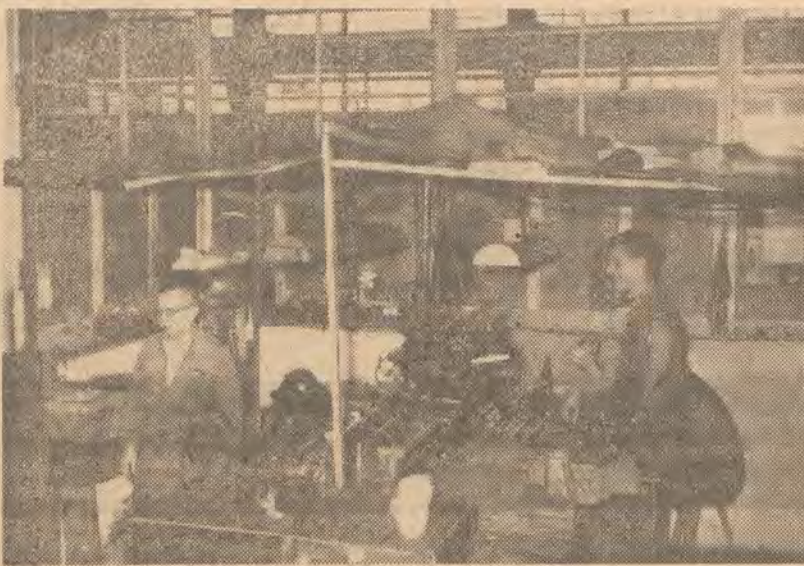
Diese Überdachung in Rs, die schon einige Jahre die dort arbeitenden Kollegen und das Material vor Nässe schützt, gehört nun endlich der Vergangenheit an. Die Scheiben in der Dachkonstruktion wurden verrottet und zerbrochene durch ganze ersetzt. Muß so etwas denn immer so lange dauern? Die Kollegen der Brigade „7. Oktober“ werden sich freuen, daß endlich dieses Provisorium verschwindet
