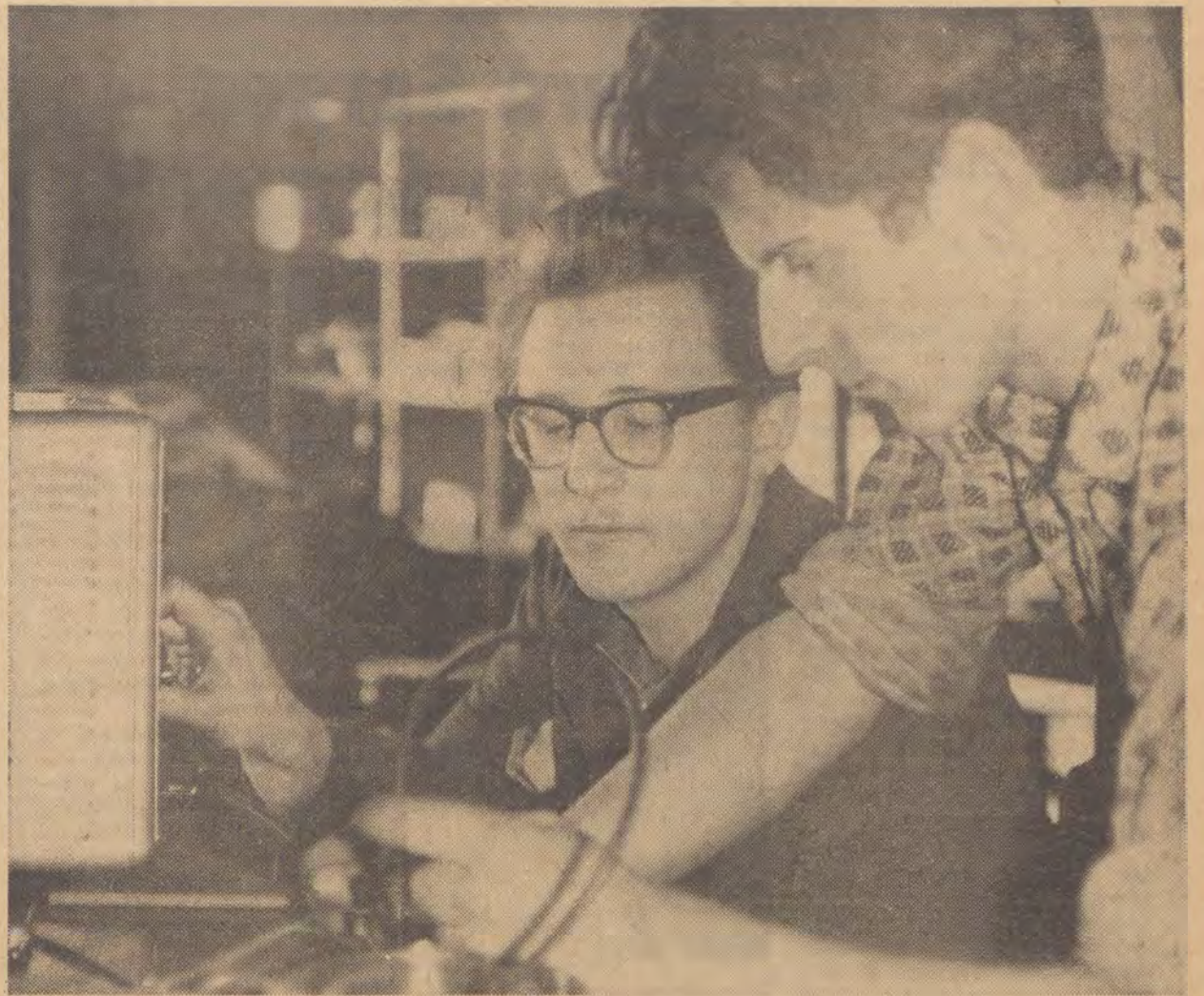
Auf dem Bild sind die Brigademit-glieder Jugendfreund Hackbarth und Jugendfreund Hönicke bei einer Mes-sung mit dem Stegdickenprüfgerät für die neu entwickelte KW-Kupplung.
