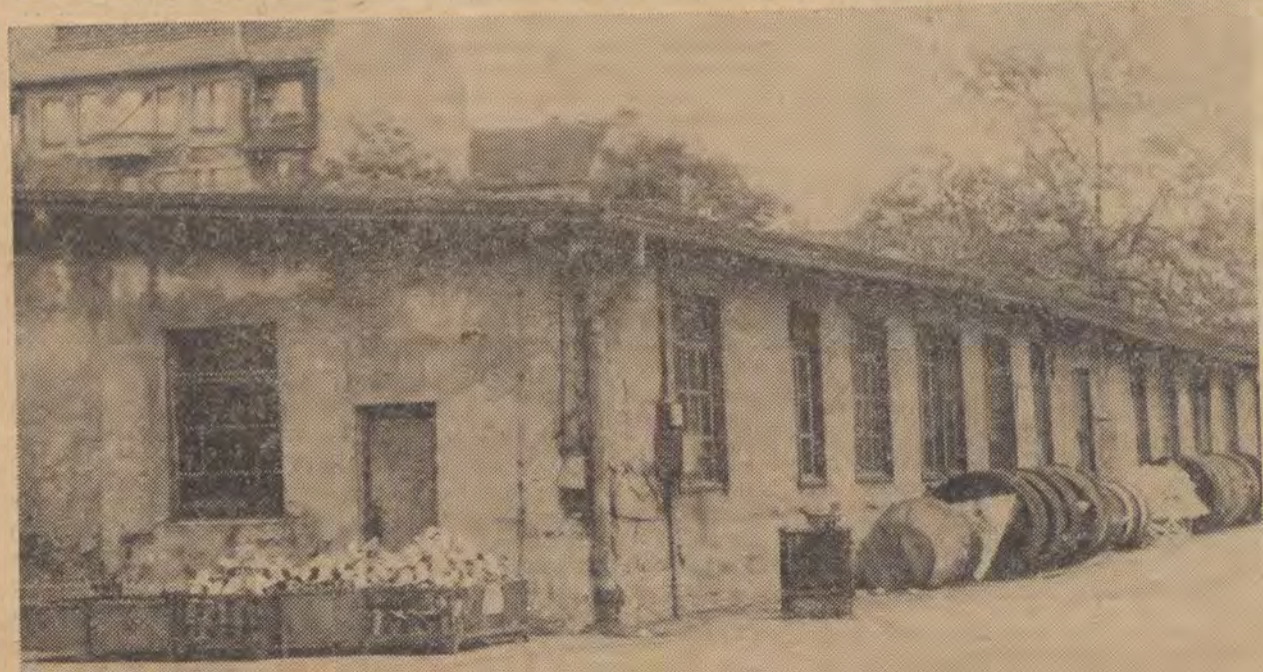
Ansicht des baufälligen Bereitstellungslagers, Gebäude 93, vor der Rekonstruktion.
