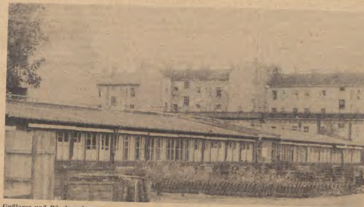
Gußlager und Bürobaracke auf der Pfahlgründung am Eingang Reinbeckstraße vor der Rekonstruktion.
