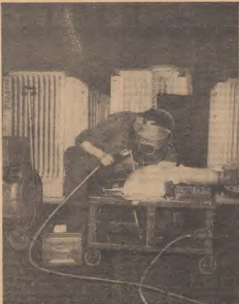
Qualität für den 380-kV-Trafo (oben) und für den Baukastenschalter (links unten) setzt das Können der Trafobauer und Schaltermonteure gleichermaßen voraus.
