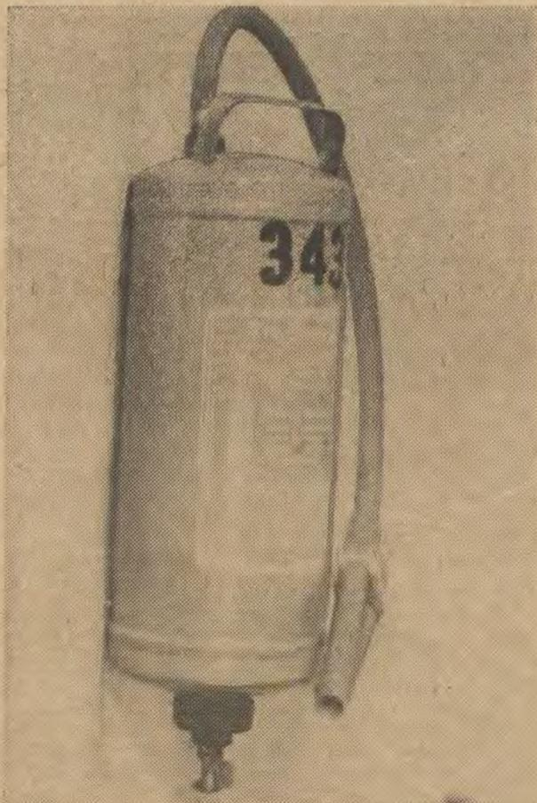
**Trocken-(Pulver-)Lösch器 XP 6 Hf**
