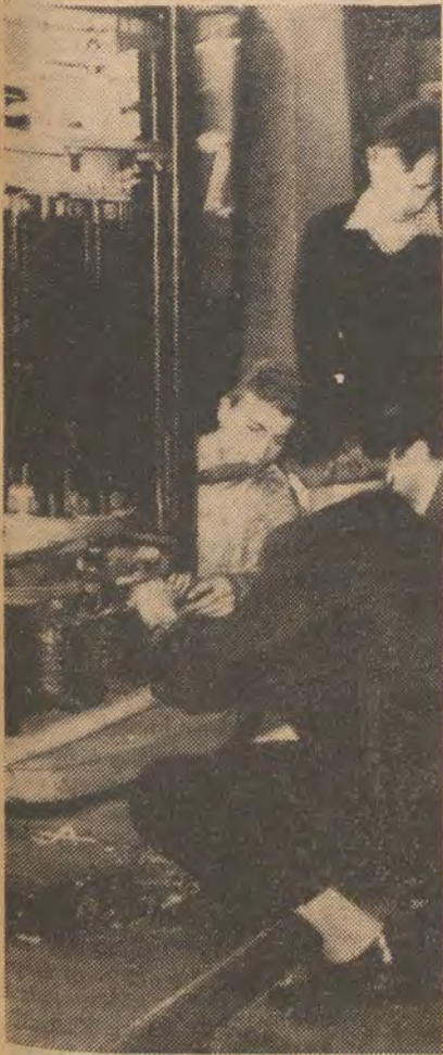
Immer wieder gilt es, Verbesserungen für die Fertigung und Montage der Stufenschalter zu finden
