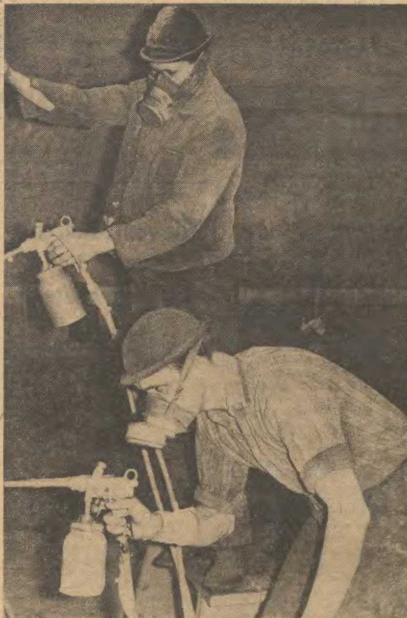
Die Kühlrippen der Trafos können mit der verlängerten Spritzpistole besser gespritzt werden. Ein Vorschlag der Technologie des O-Betriebes, der sich bezahlt macht. Unser Foto zeigt Jürgen Damerau (unten) und Heinz Gronau bei Spritzarbeiten
