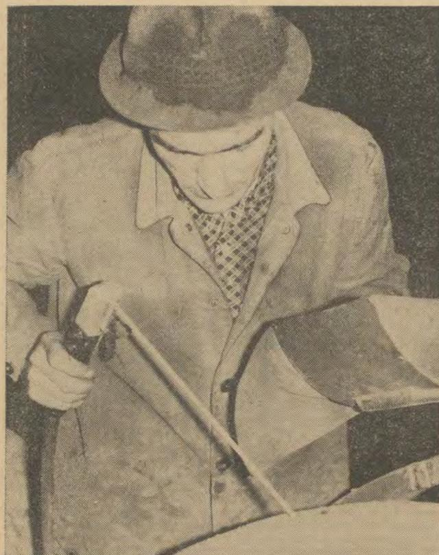
BEI DER GEGENWÄRTIGEN SCWEISSUNG der Kugelkessel mit Elektroden-Handscheidungen zeigt unser Bild den Schweißer Eugen Josten. Die Schweißfuge wird lagenweise mit Elektroden-schweißglut gefüllt. Diese Art der Fertigung ist verhältnismäßig aufwendig und kostspielig. Wie sich eine sozialistische Arbeitsgemeinschaft die rationellere Bearbeitung vorstellt, zeigt unser nebenstehendes Bild
