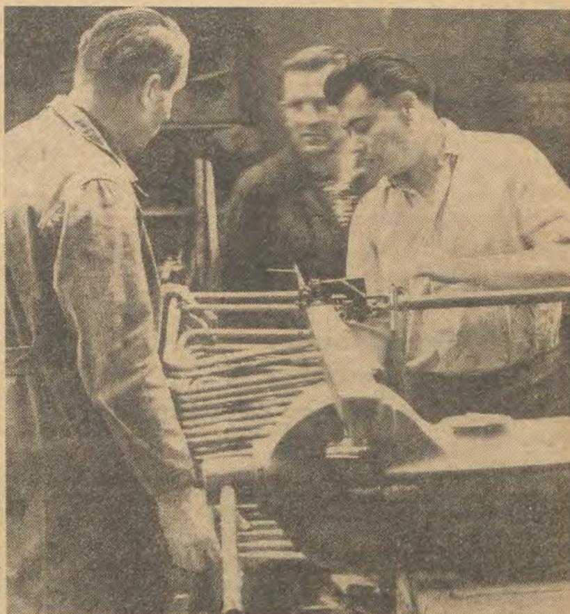
Die Kollegen Horst Groß, Georg Kühnle und Günter Schulz (v. l.) beim Biegen einer Rohrschlange mit der neu entwickelten Vorrichtung, die nicht nur eine höhere Leistung zuläßt, sondern auch den Arbeitsgang erleichtert
