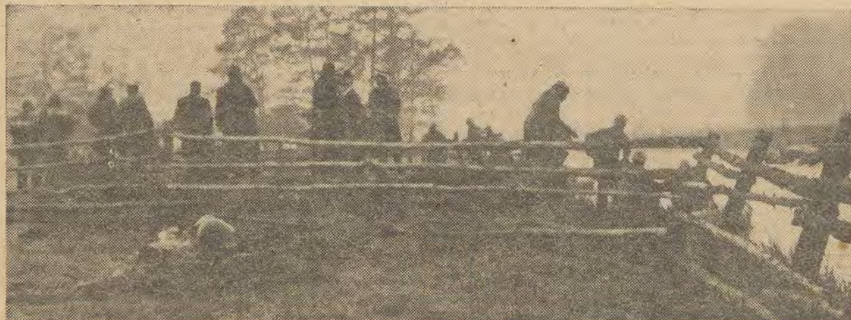
Bild links Mitte: Die Pioniere haben alle notwendigen Maßnahmen zum Überwinden des Wasserhindernisses getroffen. Angehörige der eingetroffenen Hundertschaft übernehmen die Sicherung.
