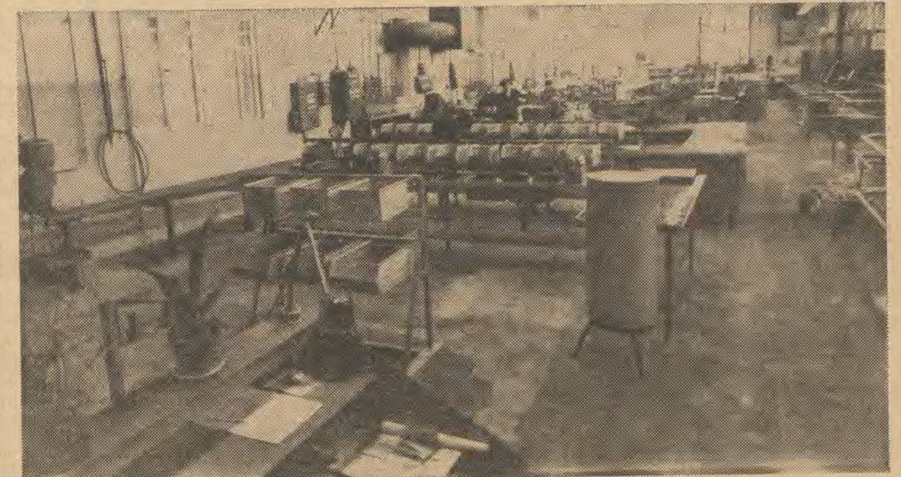
Die zweite Rekonstruktion in der BBS bereitet den Produktionsbeginn der Schaltschränke ab Januar 1969 nach modernsten Gesichtspunkten vor. An der Realisierung der Rekonstruktion nahmen alle Lehrlinge unter der Leitung ihrer Ausbilder in den verschiedensten Formen teil.
