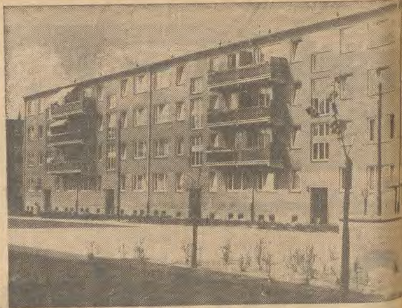
Ein Wohnblock der AWG „Berliner Bär“, Rudower Straße
