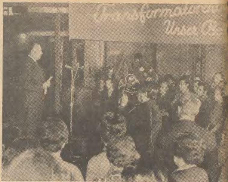
Die Trafobauer hielten Wort. Der Thierbach-Transformator verließ schließlich am 30. Juni das Werk. Am 26. Juni wurden in einer kleinen Stunde die Prüfprotokolle übergeben (unser Foto). Foto: Reba
