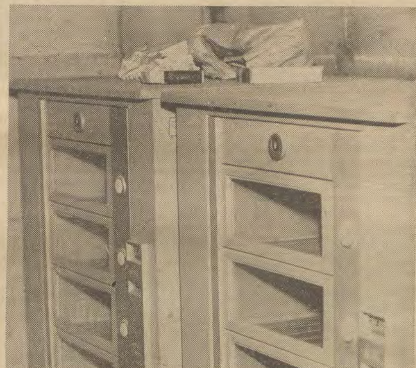
Im Westeingang des Kopfbauwerks langweilt sich dieser leere Automat, den die Kollegen aus unerklärlichen Gründen mit Abfällen „krönten“.
