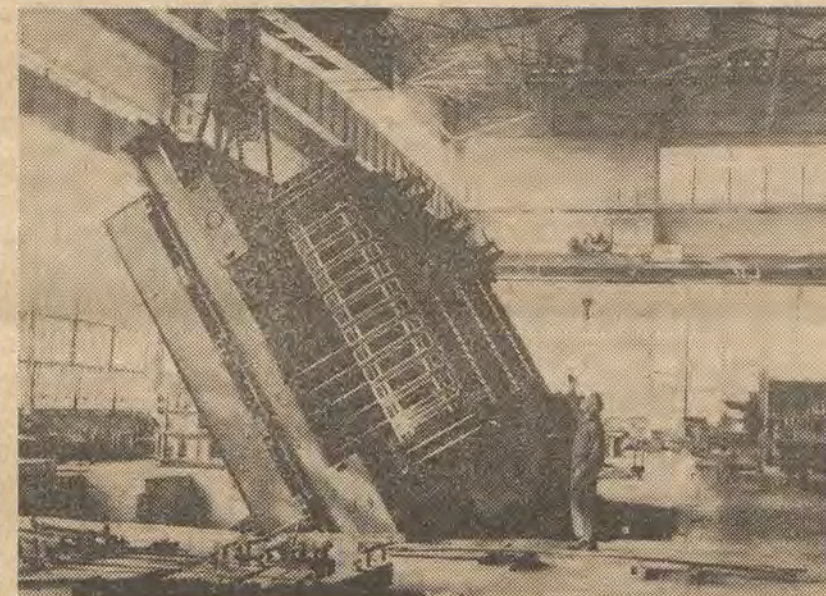
Die Kernschichtvorrichtung des Transformatorenwerkes Saporoshe.
