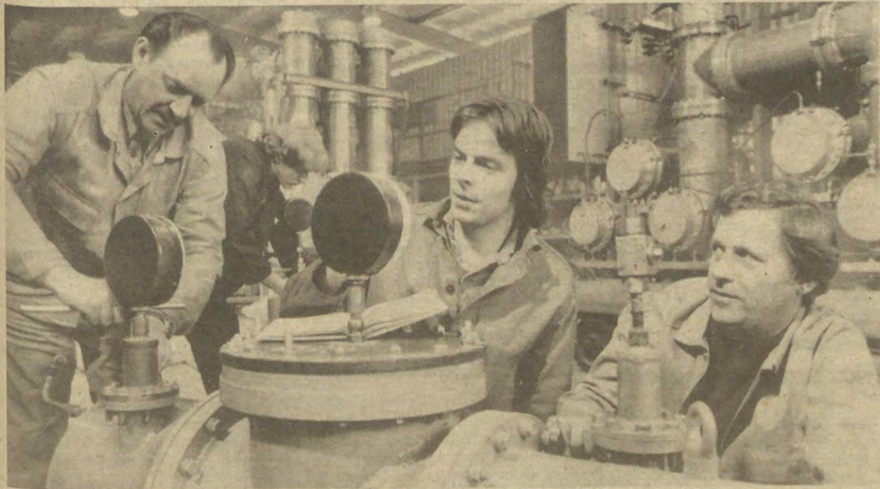
Karl-Heinz Axin, Ralph Eggers und Hans-Joachim Köbe aus N bei Meßarbeiten. Um die Nacharbeiten in der Montage zu senken und die Qualität zu erhöhen, werden die Genossen von QN monatlich eine Fehlerauswertung vornehmen und im Oktober 1977 eine Qualitätskonferenz organisieren.
