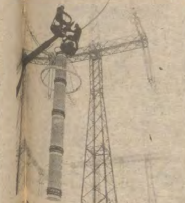
Unser Foto zeigt den Bau von Freileitungen der Verteilerstation „Dnepr“.
