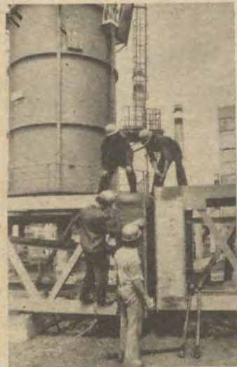
Sowjetische Arbeiter bei Montagearbeiten an der 3. Ausbaustufe des Orenburger Erdgaskomplexes.
