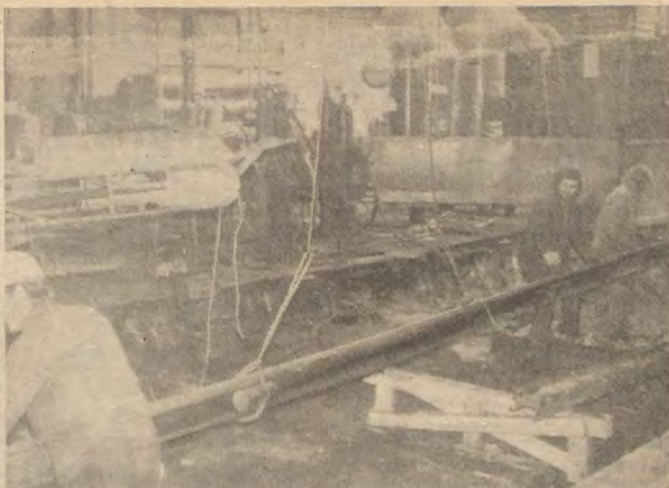
Viel Geschick und Präzision sind beim „Ausschlachten“ der alten Gleisanlage notwendig.
