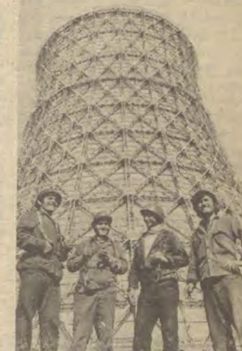
Unser Foto zeigt den Bau des ersten Atomkraftwerkes in Transkaukasien
