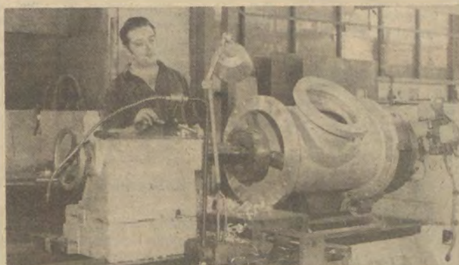
Radiergummi glättet Metall — so bezeichnete ein Reporter das neue Polierverfahren MHK, das in Niederschönhausen bei GSAS-Teilen Anwendung findet. Das Jugendenutzungskollektiv sorgt für eine breite Anwendung dieses Patents in unserem Kombinat.
