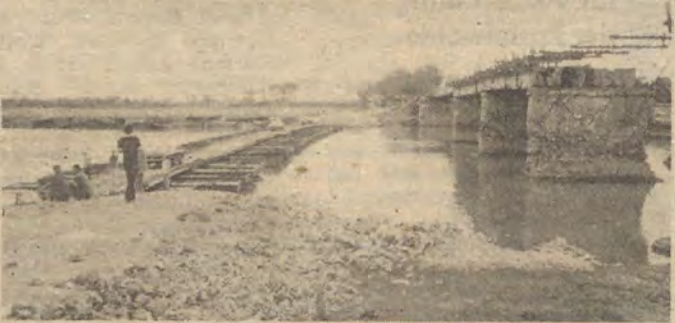
Überall in Nordvietnam: Durch die chinesische Aggression zerstörte Brücken.
