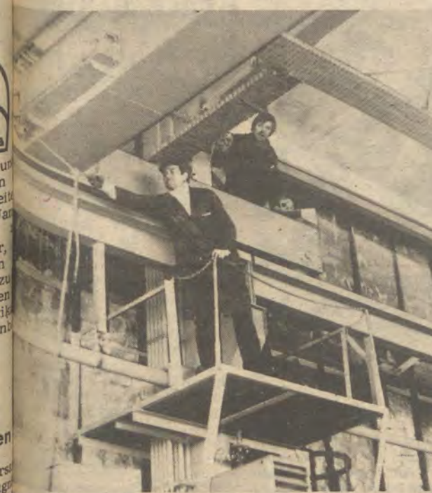
Brückenkran wird abgebaut.
