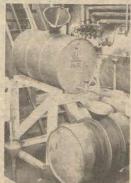
Wurden bisher die ölhaltigen Wasserkondensate im O-Betrieb dem in Werk vorhandenen Ölabscheider zugeführt werden diese nunmehr weit ökonomischer direkt vor Ort wie hier in Mtr entölt.
