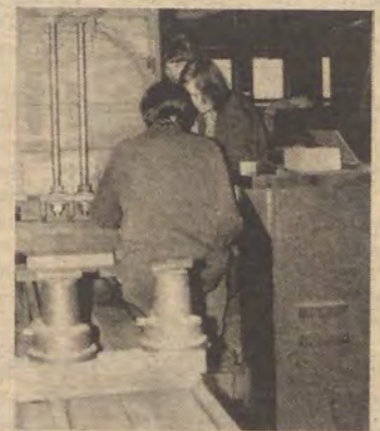
Fertigung der Kerne für den 50-kVA-Trafo.
