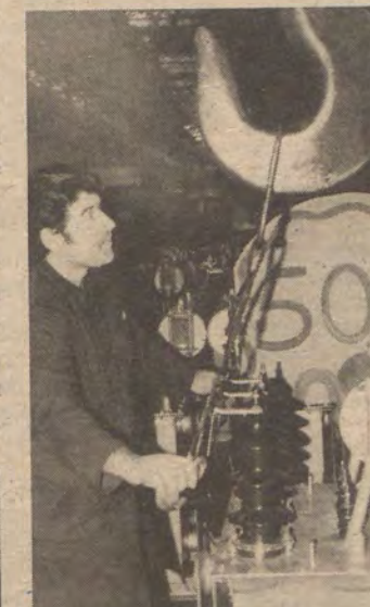
Der 500. Doka, Meister Günter Fuhr rückt ihn gut ins Bild. In den Morgenstunden des 27. November bestand der Trafo erfolgreich seine Prüfungen.
