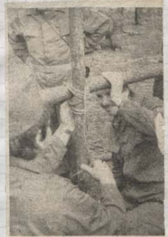
Eine Seilverbindung wird begutachtet.
