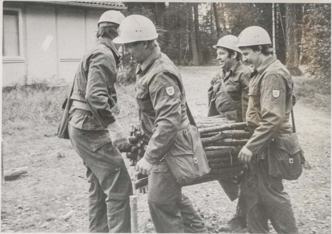
Haletransport für den Faschinenbau
