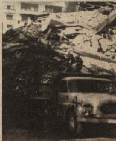
MIT ERSTEN ARBEITEN wurde sofort nach der Katastrophe begonnen. Werktätige und Angehörige der Streitkräfte sind ständig im Einsatz.
